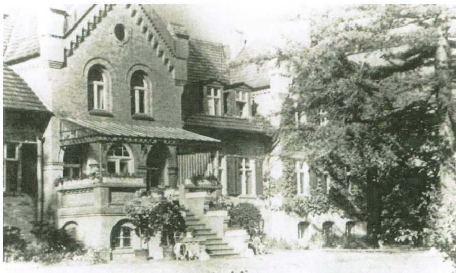
Gutshaus 1935 Rückseite mit Terrasse, Foto Dr. Wierling
